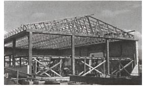
Der Dreieck-Streben-Bau ermöglichte holzsparende Konstruktionen für Dachstühle.
