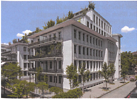
Die Fassade der Aufstockung orientiert sich am Bestand.
