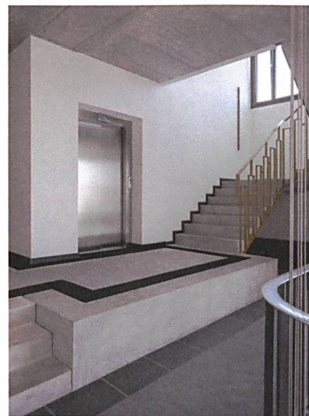
Ein Versatz im Treppenhaus zeigt die Nahtstelle zwischen Bestand und neuen Obergeschossen.
