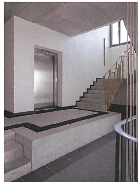
Ein Versatz im Treppenhaus zeigt die Nahtstelle zwischen Bestand und neuen Obergeschossen.
