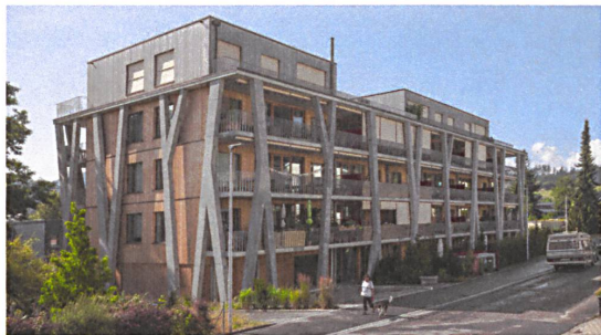
Die Betonstützen und die Laubengänge wurden nach dem Holzbau errichtet.
