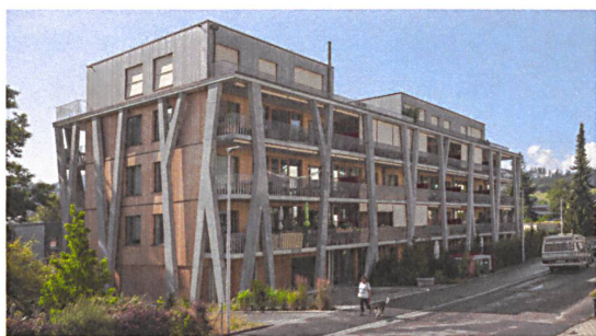
Die Betonstützen und die Laubengänge wurden nach dem Holzbau errichtet.
