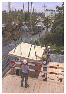
Bauarbeiter hieven das vorgefertigte Deckenelement an die richtige Stelle.
