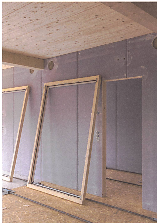
In den Bürogeschossen bleiben die Brettstapeldecken sichtbar.
