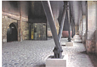
Umbau Werkhof, Fribourg Bakker & Blanc, Lausanne
