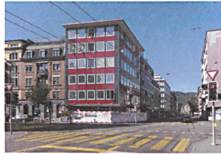
Umbau Stadthaus Seebähni, Zürich Huggenbergerfries, Zürich
