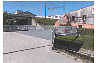
Brücke für Langsamverkehr, Yverdon-les-Bains VD Atelier Descombes & Rampini, Genf
