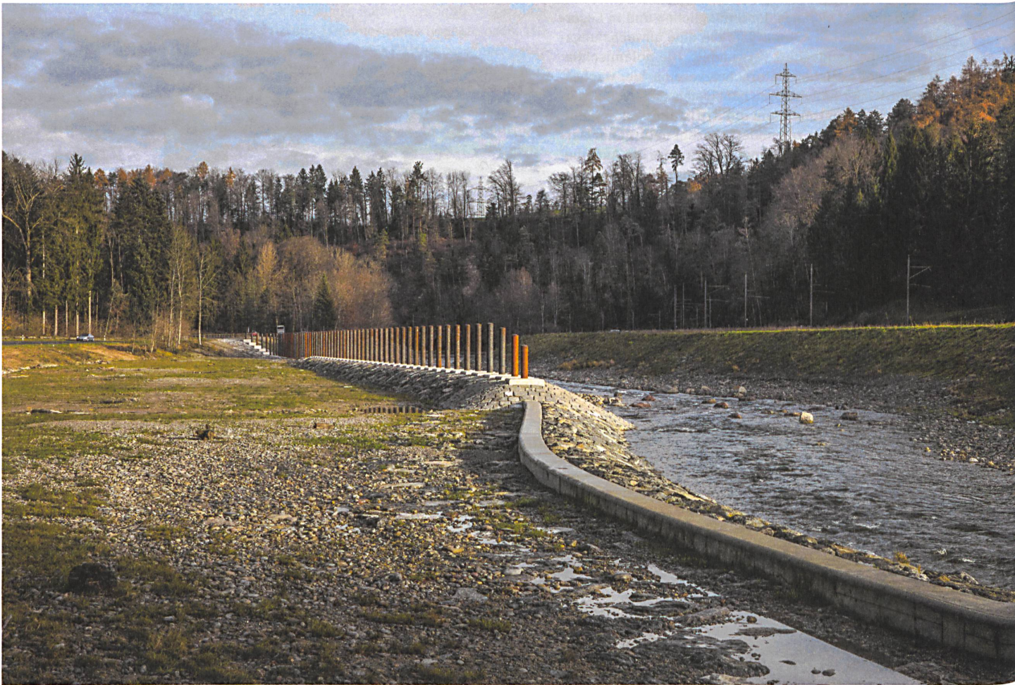
Der 350 Meter lange Schwemmholzrechen in der Sihl ist das Resultat eines landschaftsarchitektonischen Blicks auf einen Infrastrukturbau.
