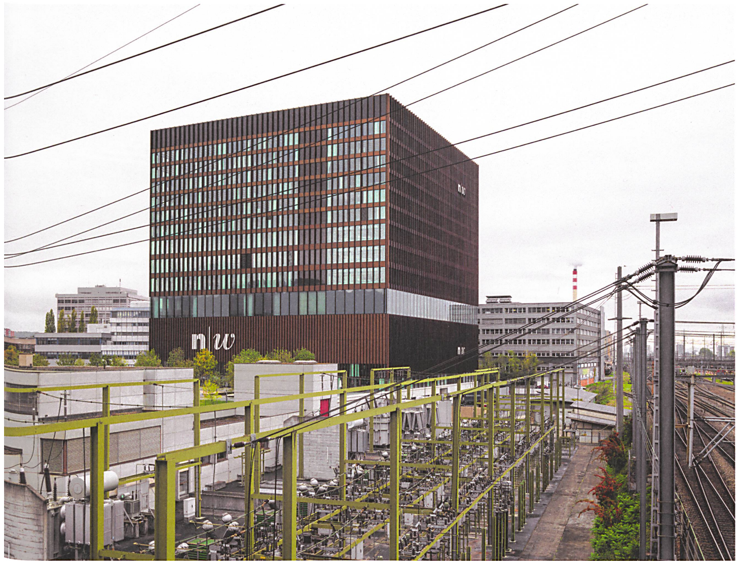
Der Neubau der Fachhochschule Nordwestschweiz ragt hinter einem Umspannwerk beim Bahnhof Muttenz 64 Meter in die Höhe.
