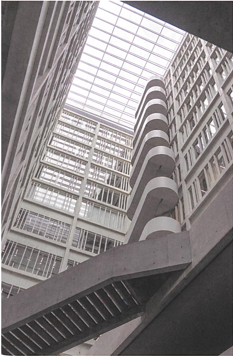
Freistehende Treppen verbinden die Geschosse in den beiden Innenhöfen.
