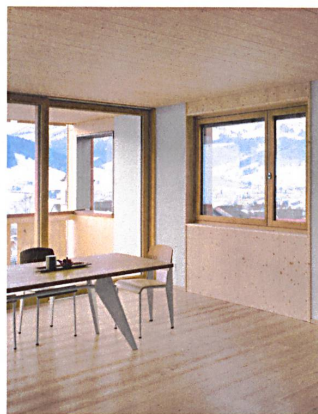
39 Die Aussenwände bestehen aus verdübeltem Massivholz.
