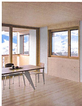
39 Die Aussenwände bestehen aus verdübeltem Massivholz.
