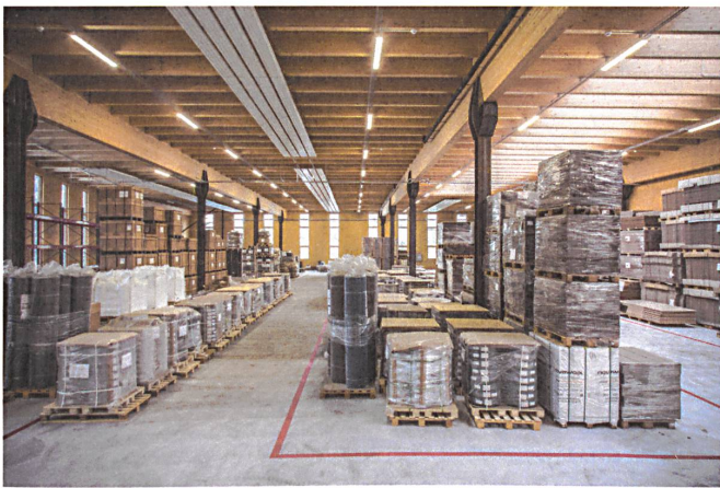
38 Die Firma Lico stockte ihre Lagerhalle in Müstair mit Holz, Beton und Stahl auf.
