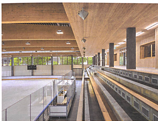
26 Das Holzdach sitzt auf Betonstützen.
