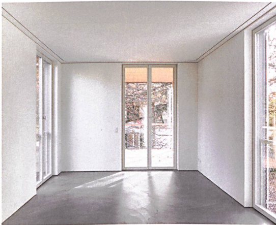
17 Die Wände im Anbau bestehen aus weiss gestrichenen Dreischichtplatten.
