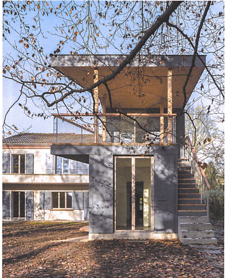
17 Der Anbau erweitert die Berner Villa aus den Zwanziger Jahren.
