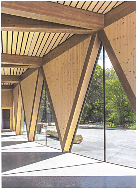
Les éléments triangulaires en bois sont posés en équilibre sur une pointe.
