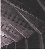
10 La structure porteuse se compose de panneaux lamellé-croisé assemblés par tenons-mortaises multiples.
