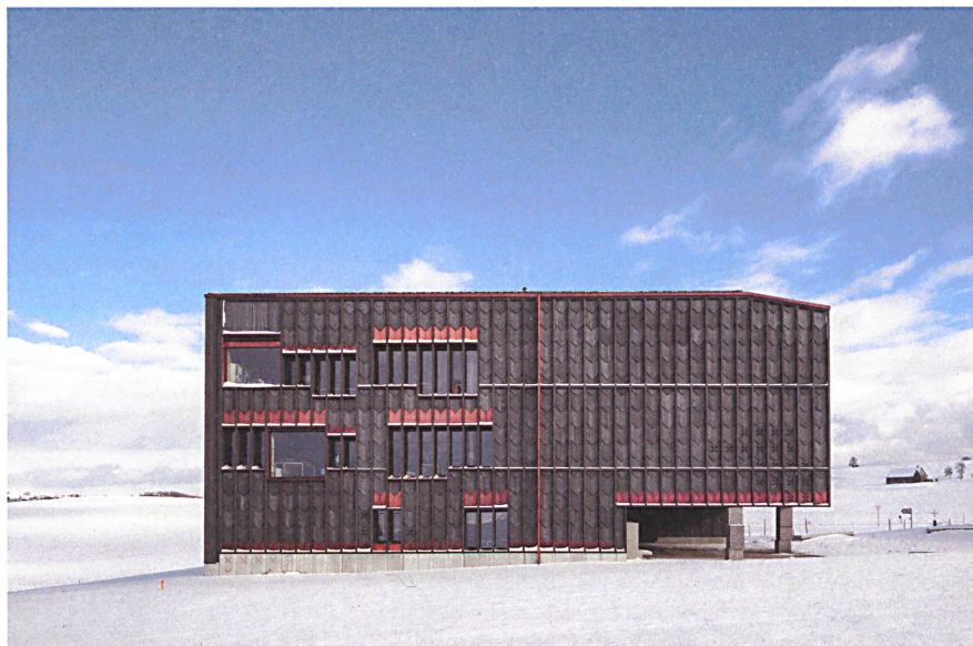
12 À la périphérie d'Orsonnens se dresse la nouvelle école avec sa façade habillée de grands bardeaux.
