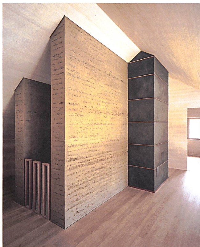
Zwei Stampflehmmauern regulieren die Luftfeuchtigkeit und speichern die Wärme des Stückholzofens.
