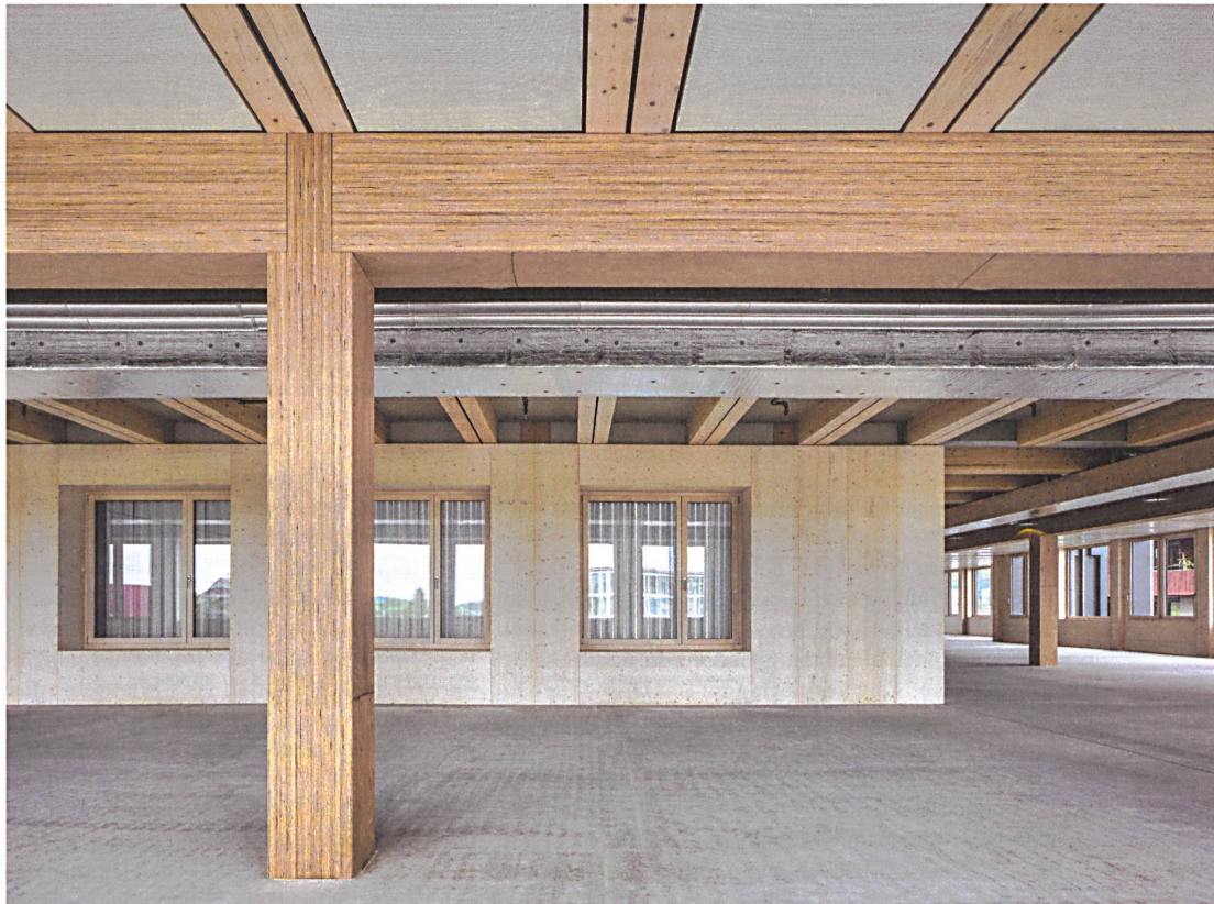
Stützen und Unterzüge aus Baubuche gliedern den Raum und ermöglichen einen bürotypischen Raster.
