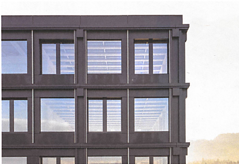
Die Alufassade lässt den Holzbau dahinter erahnen. Foto: Markus Bertschi
