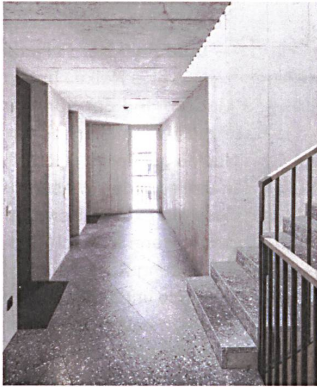
Ein Oberlicht und ein Fenster bringen Tageslicht ins Treppenhaus.
