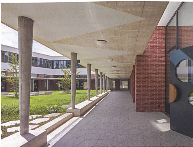
Primarschulhaus Feldmeilen: Der Aussen-gang rahmt den Hof, verbindet den Neubau mit dem Altbau und die vier Treppenhäuser miteinander.
