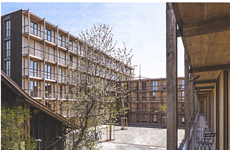
Hagmann-Areal in Winterthur: Eine schmale Veranda vermittelt zwischen Innenhof und Wohnung.
