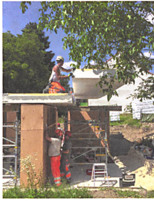
Boden- und Deckenplatten sowie vier Holzmodule wurden in zehn Tagen aufgerichtet.
