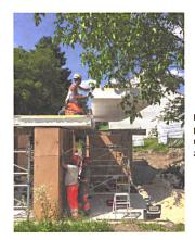
Boden- und Deckenplatten sowie vier Holzmodule wurden in zehn Tagen aufgerichtet.
