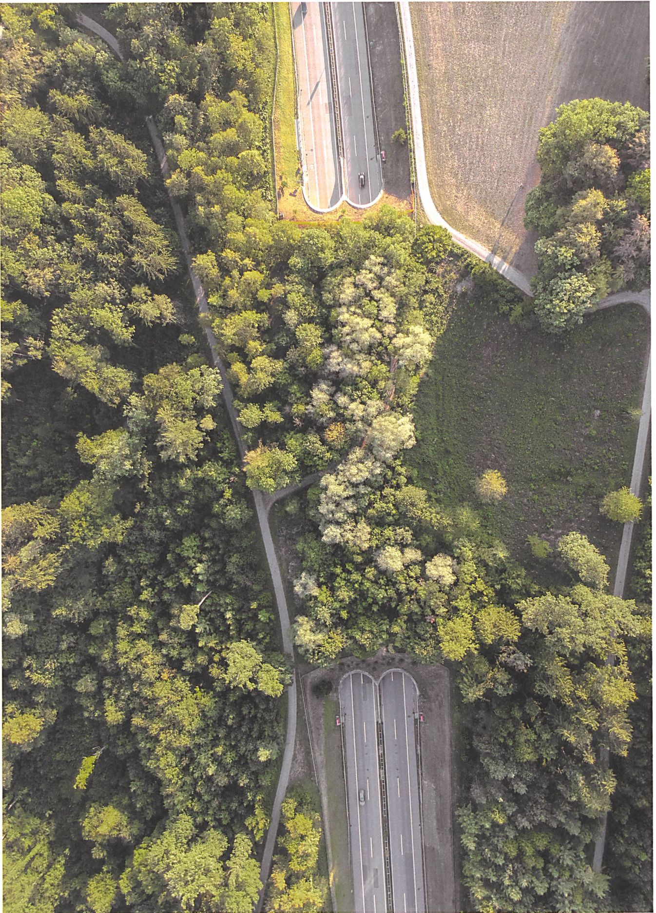
Grünbrücke Aspiholz bei Müllheim: Die Überdeckung für Wildtiere schliesst eine Wunde in der Landschaft zwischen dem Thurgauer Seerrücken und dem Thurtal.
