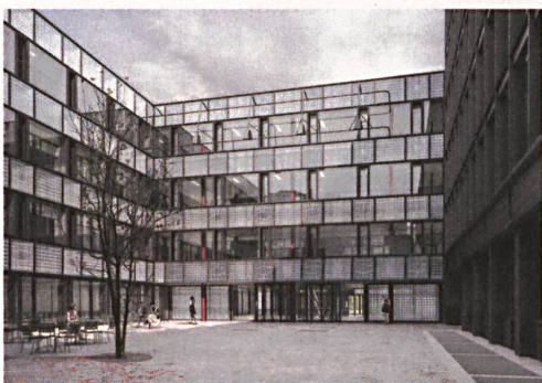
«Broschen» aus Glasbausteinen prägen die Fassade.
