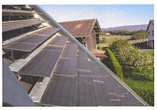
Eine einfache Klemmkonstruktion hält die Photovoltaik-Module. Fotos: Vincent Mermod
