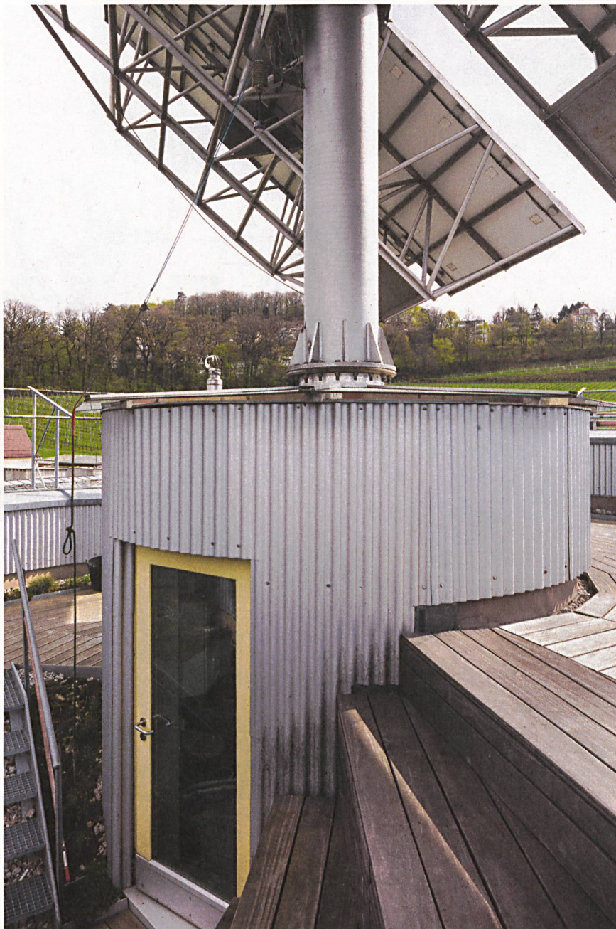
Der PV-Schirm schützt die Dachterrasse vor Sonne oder Regen.
