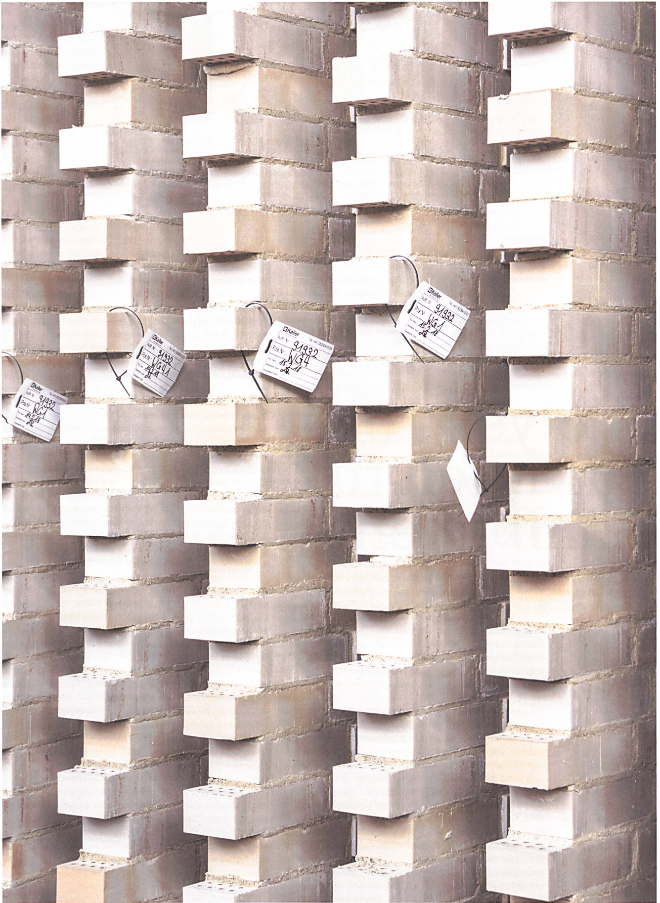
Vorgefertigte Massivmauerelemente müssen «just in time» auf der Baustelle eintreffen, abgestimmt auf die Versetzerienfolge des Bauablaufs.
