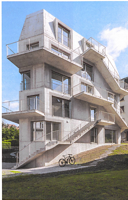
Balkone und Treppenläufe erweitern das Wohnhaus in Renens um eine zweite, luftige Raumschicht.
