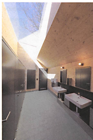
Ein langes Oberlichtband lässt viel Licht ins hölzerne WC-Haus fallen.
