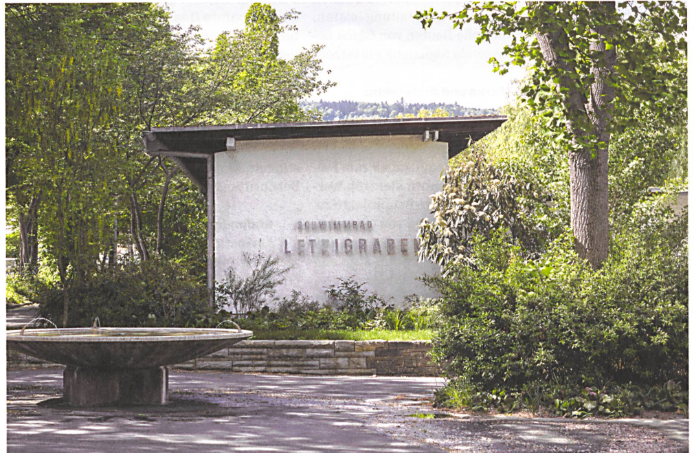
Passt zum historischen Bestand: die Beschriftung des Schwimmbads Letzigraben.
