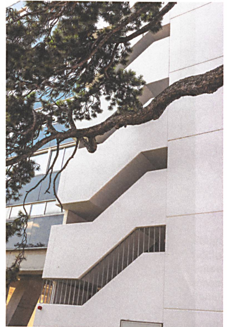
Flacheisen binden den in die Ostfassade geschobenen Treppenturm nun erdbebensicher an die Tragstruktur.
