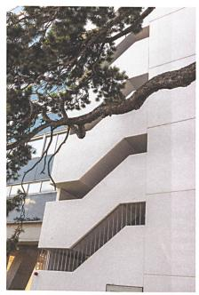
Flacheisen binden den in die Ostfassade geschobenen Treppenturm nun erdbebensicher an die Tragstruktur.
