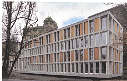
Der Neubau ist ein auf Stützen ruhendes Betonregal.
