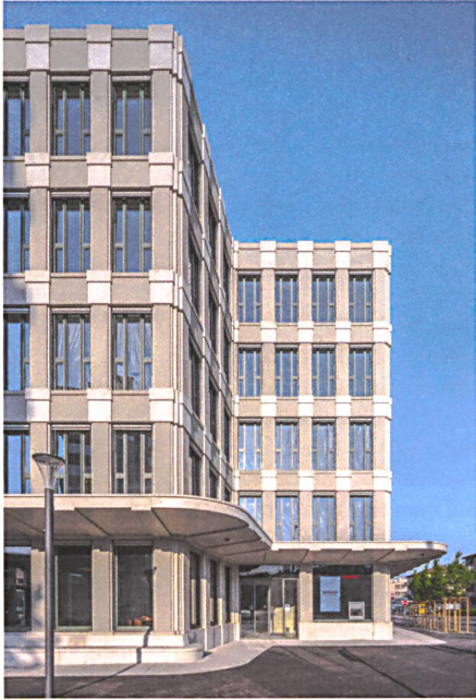
Bankenpalazzo im periurbanen Niemandsland: In der aus dem Volumen geschnittenen Ecke liegt der Eingang.
