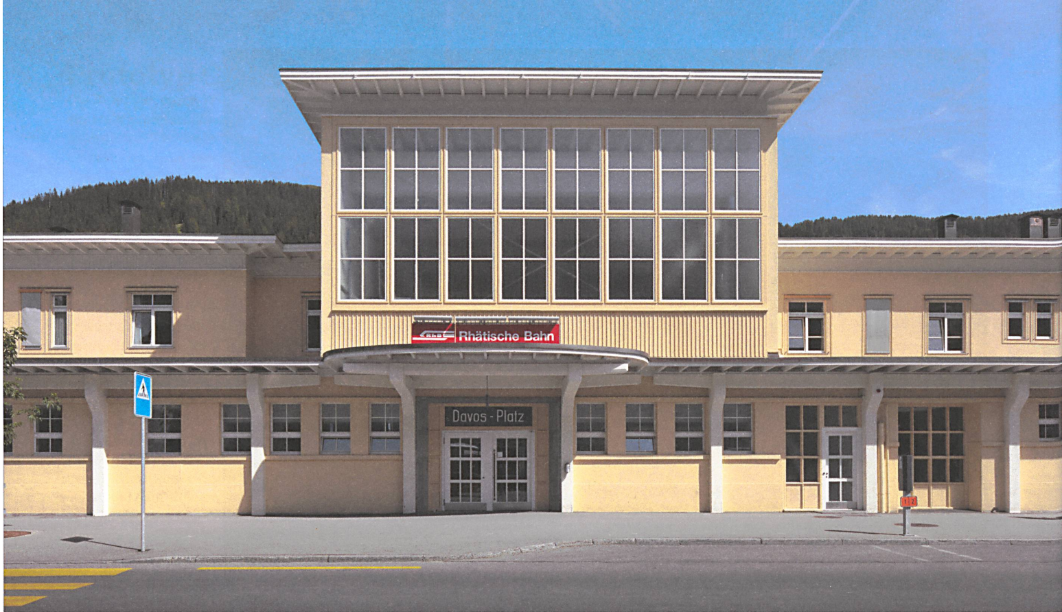
Als einen seiner letzten Bauten realisierte Rudolf Gaberel den Bahnhof Davos Platz. Nun haben Maurusfrei Architekten das Denkmal mit der Laterne, der fein detaillierten Fassade und den zierlichen Stützen renoviert.
