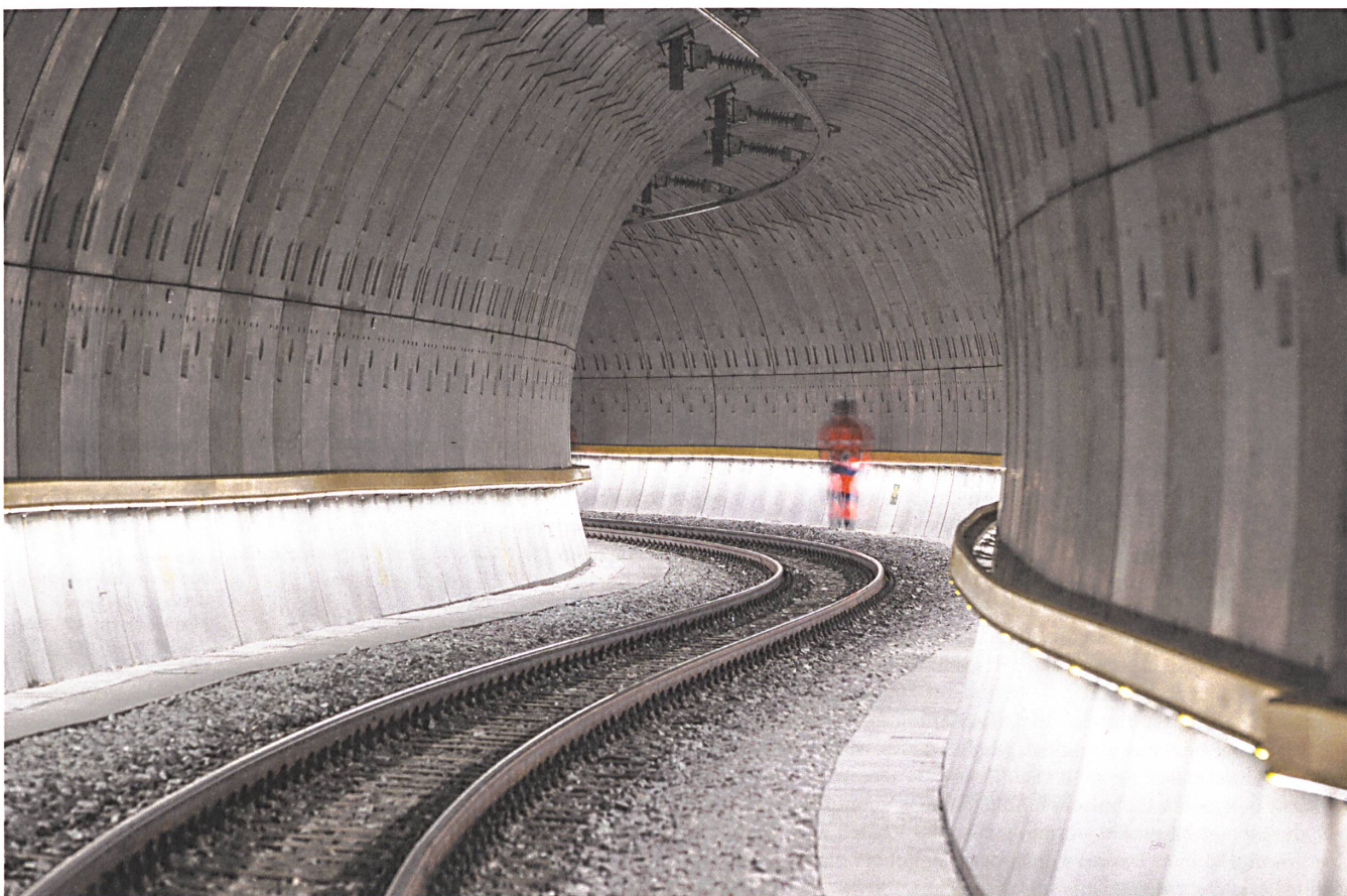
In eleganter Schlinge fährt der Zug durch den Glatscheras-Tunnel, ausgekleidet mit mehr als 1500 Betonelementen.
