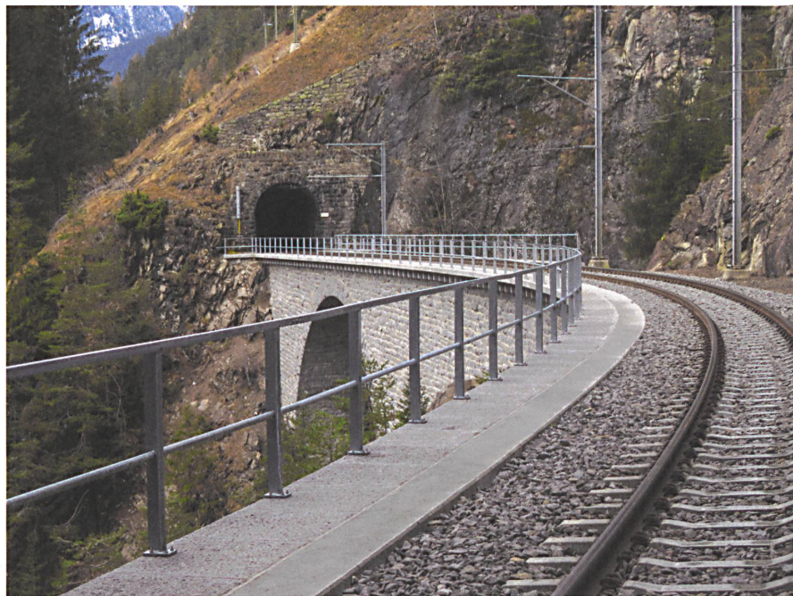
Der Kragen aus Stein, der Trog für die Fahrbahn aus Beton.
