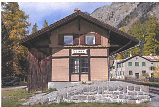
Die Station und das Ingenieurshaus (rechts) von Spinas werden renoviert. Foto: Max Galli
