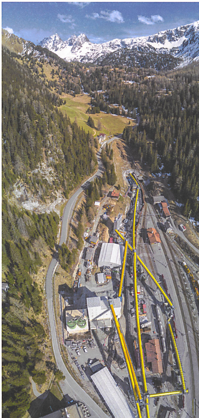
Ein Industriewerkplatz im Gebirge: die Baustelleninstallation bei Preda für den Albulatunnel. Foto: Patrick Cavelli
