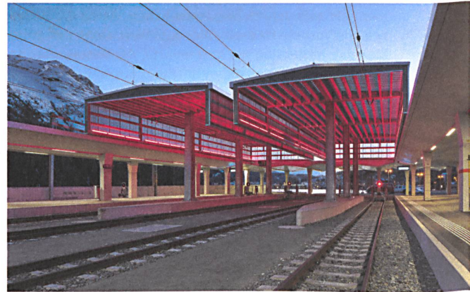
Die Lokomotiven stehen unter lichten, hohen Dächern aus Kunststoff, beleuchtet in der Nacht.
