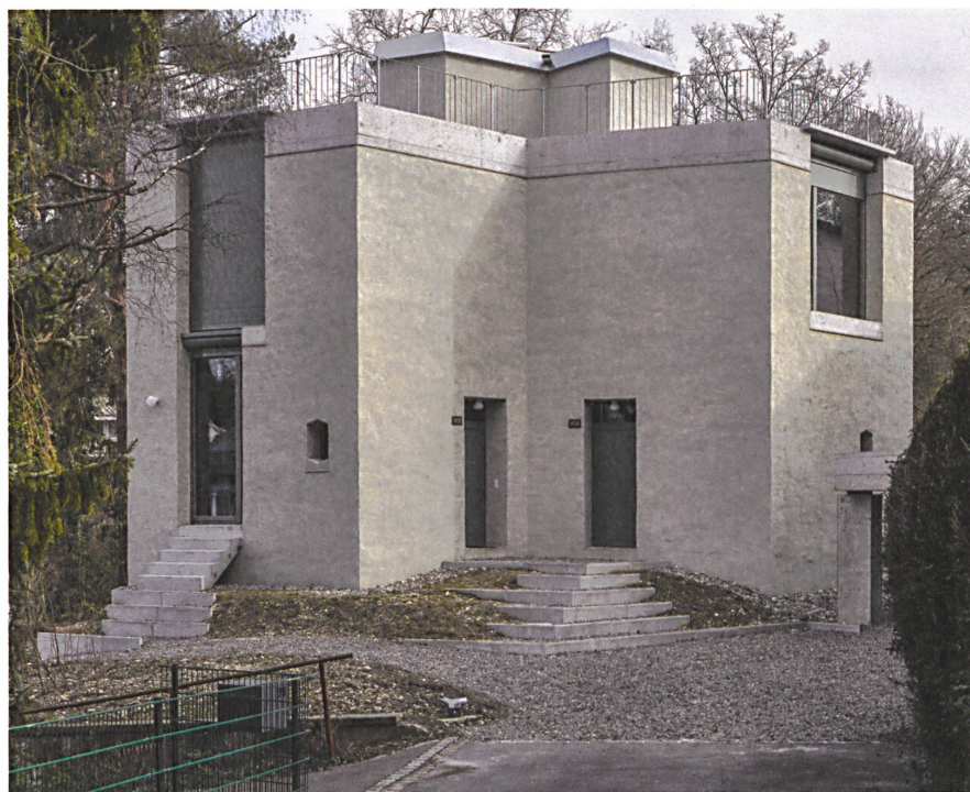
Die beiden Köpfe an der Zufahrt des Wohnhauses an der Lerchenstrasse in Basel.
