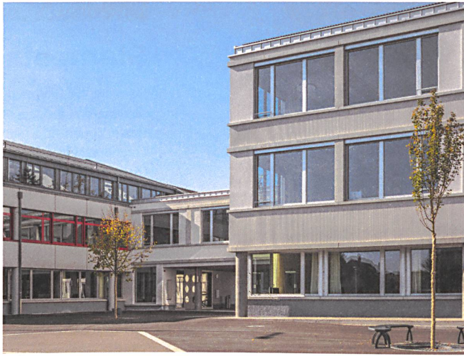
Der Neubau in Rapperswil schliesst direkt an die bestehende Schule an.
