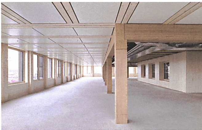
Das Holz trägt und prägt das Bürohochhaus 22 auf dem Suurstoffi-Areal in Risch-Rotkreuz. Foto: Markus Bertschi
