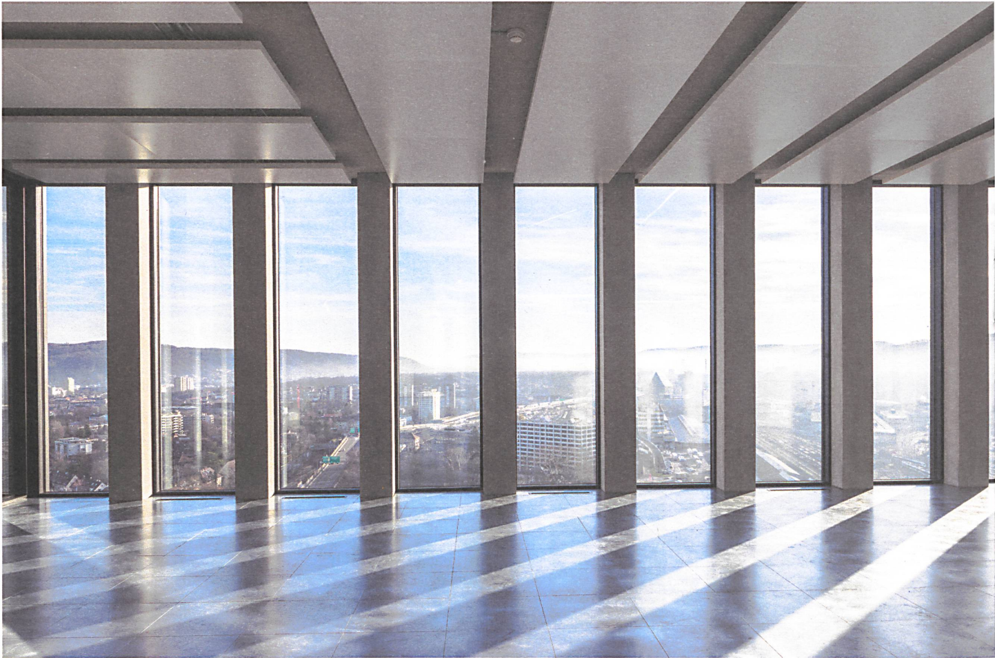
Fassadenpfeiler und Decke zeigen die ungeschminkte Tragstruktur. | Les piliers de la façade et le plafond montrent la structure porteuse à l'état brut.
