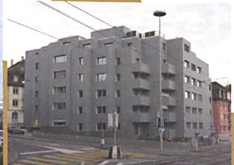
Publikumspreis MFH Hofwiesen-/ Rothstrasse, Zürich
