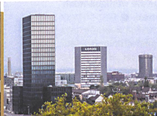
3. Preis Neubau Grosspeter Tower, Basel
