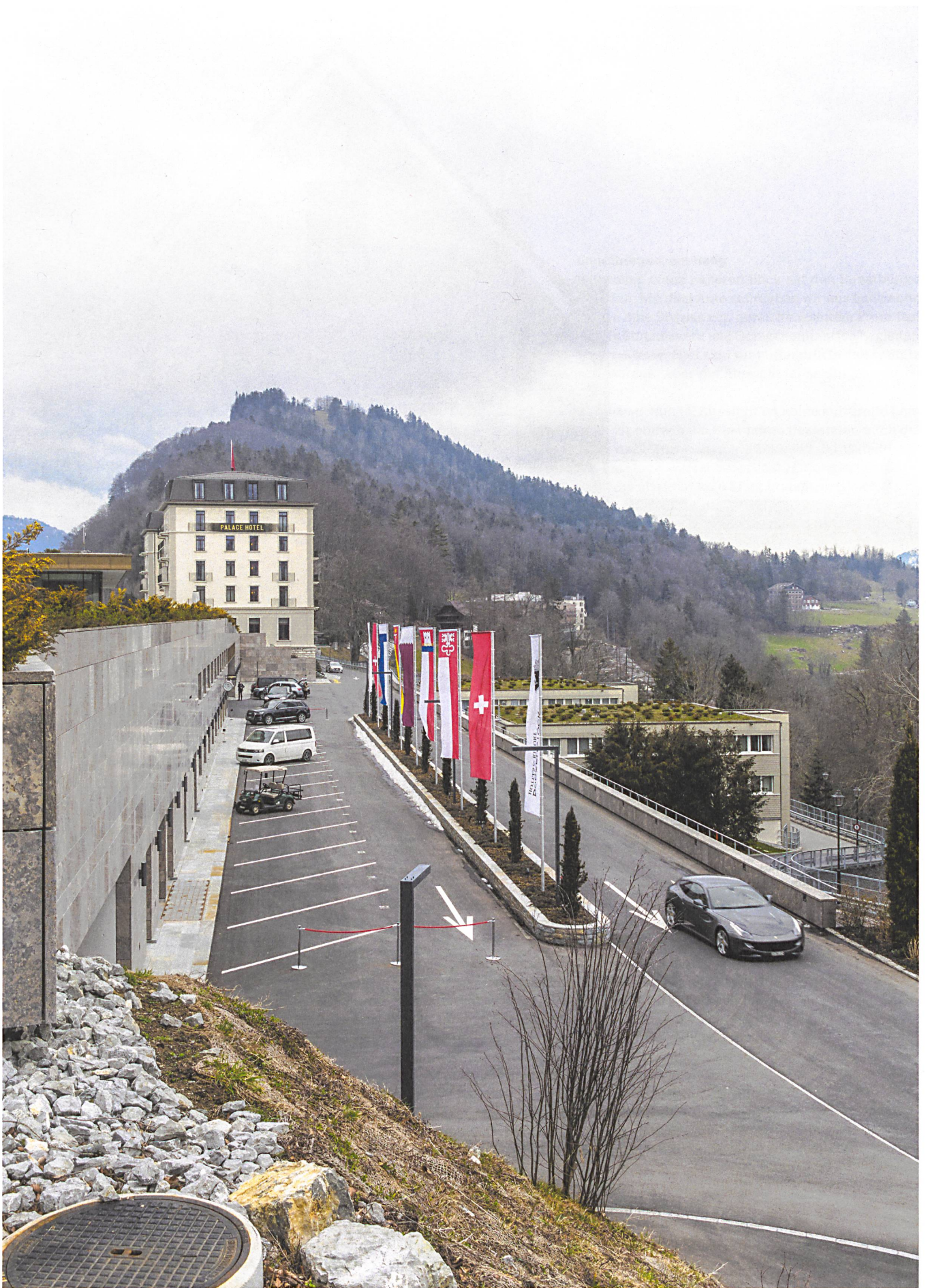
Könnte auch die Anlieferung eines Flughafens sein: eine schein-massive Stützmauer der erneuerten Hotelanlage auf dem Bürgenstock bei Luzern.
