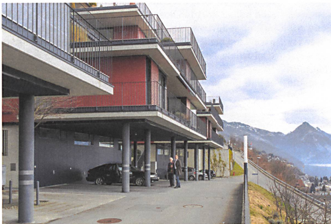
Es geht auch ohne Stützmauer. Das ergibt gleich eine offenere, angenehmere Stimmung.
