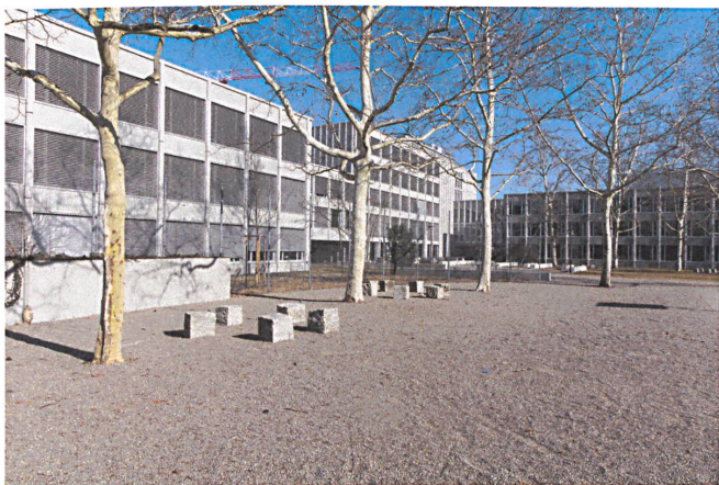
Die neue Fassade macht die einzelnen Gebäudeteile zum einheitlichen Ensemble.
