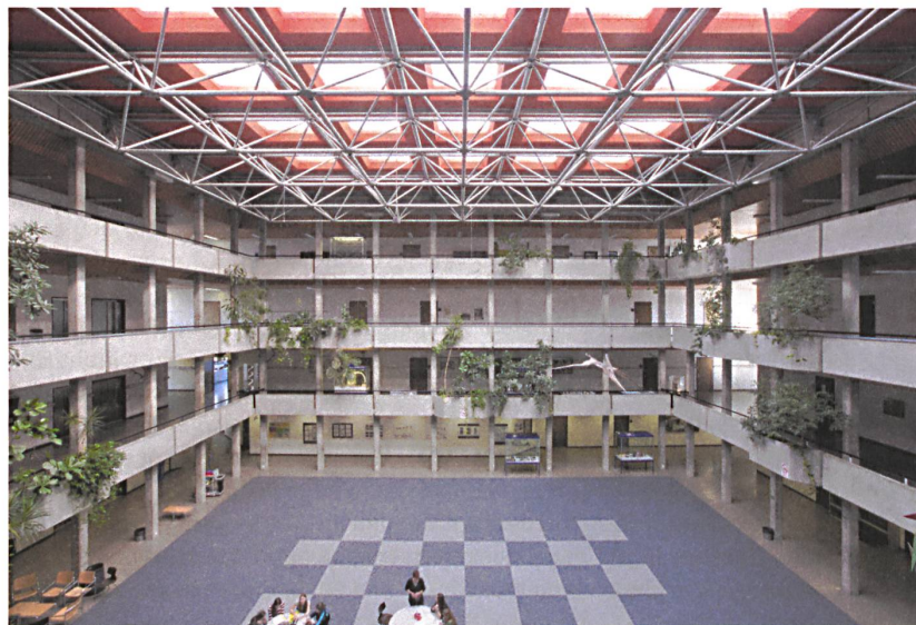
Das Atrium des Bäumlhofs vor der Sanierung: Der weite Luftraum erinnert an ein Parkhaus.
