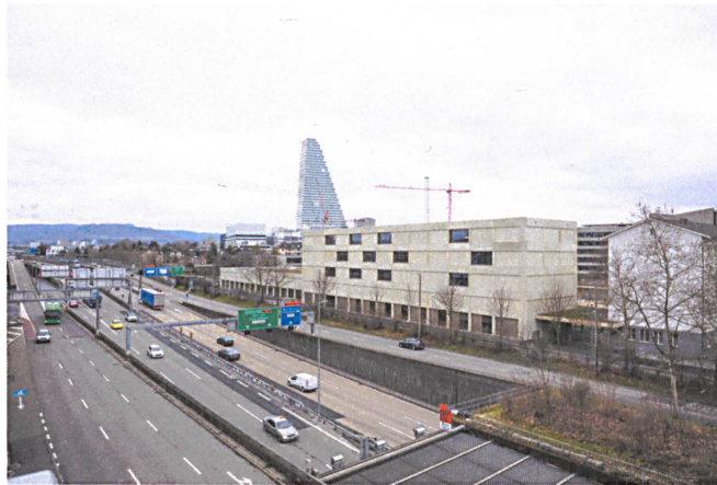
Die Strassenfassade gegen den Ostring ist mehrheitlich geschlossen. Das Schulhaus öffnet sich gegen den Innenhof, den es mit dem Altbau aus den 1950er-Jahren fasst.
