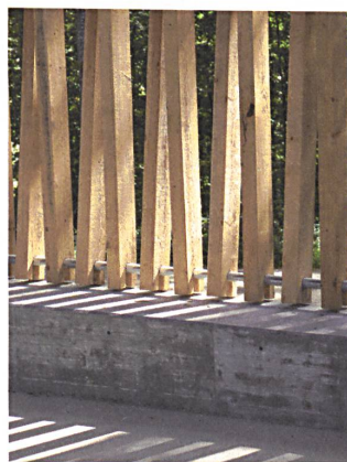
Die schiefen Fassadenhölzer stehen auf einem Metallrohr.
