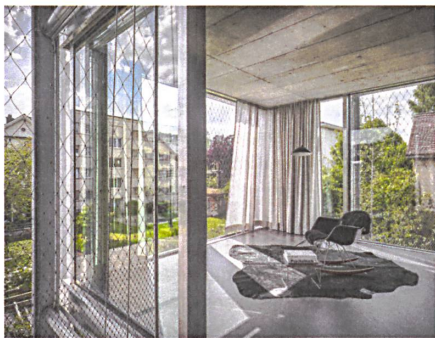
Jedes zweite Fenster lässt sich raumhoch aufschieben.
