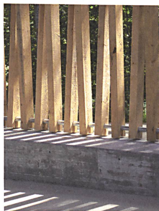
Die schiefen Fassadenhölzer stehen auf einem Metallrohr.
