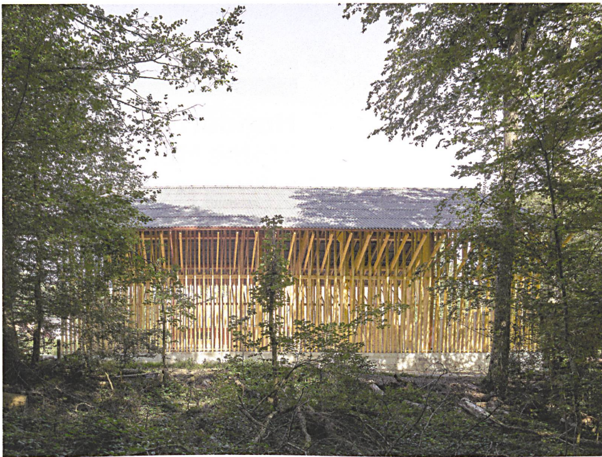
Schutzdach mit offenen Wänden für die Holzkorporation Dübendorf: 28,5 Meter lang, 20 Meter breit und 13 Meter hoch.
