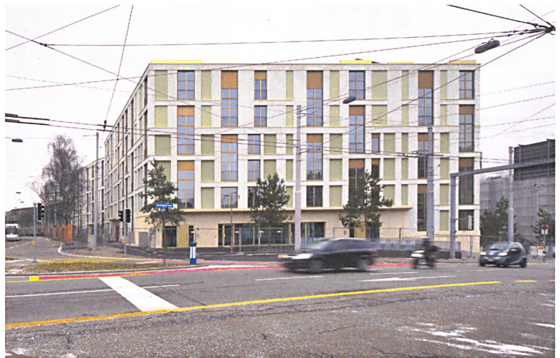
Die Fassade kaschiert die Lärmgründrisse dahinter.
