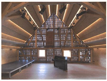
Vom Heuboden zur (Hirschenbühne): Eine neue Glasfassade hinter der Riegelkonstruktion macht den Theaterund Bankettsaal winterfest, unbehandelte Grobspanplatten an Wand und Decke sorgen für gute Akustik.
