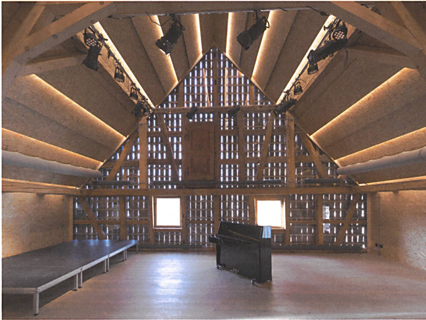
Vom Heuboden zur «Hirschenbühne»: Eine neue Glasfassade hinter der Riegelkonstruktion macht den Theater- und Bankettsaal winterfest, unbehandelte Grobspanplatten an Wand und Decke sorgen für gute Akustik.
