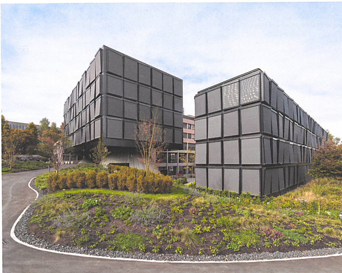
Die anthrazitfarbenen, textilen Storen hüllen die Baukörper bei Sonnenschein in ein edles Kleid.
