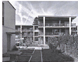
Die Siedlung Bruggliacker in Zürich ist das erste realisierte Projekt von BS+EMI Architekten.
