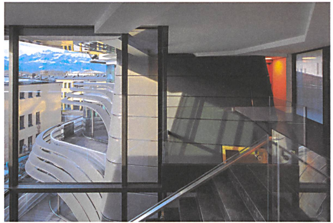
Die textilen Bänder sind Balkonbrüstung, Fassade und Treppenhauswand.
