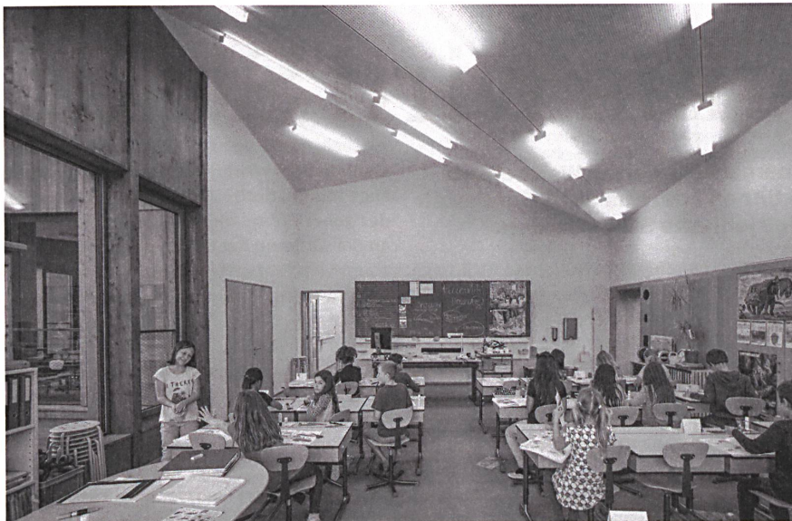
In den fast fünf Meter hohen Schulzimmern ist die Verdrehung von Raum- und Dachstruktur spürbar. Mal läuft eine Kehle über die Raumdiagonale, mal ein First.
