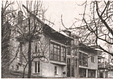
Hermann Czech baute 1983 das Haus S. in Wien mit einem um 45 Grad geneigten, überstehenden Pultdach. Foto: Margherita Spiluttini / azw
