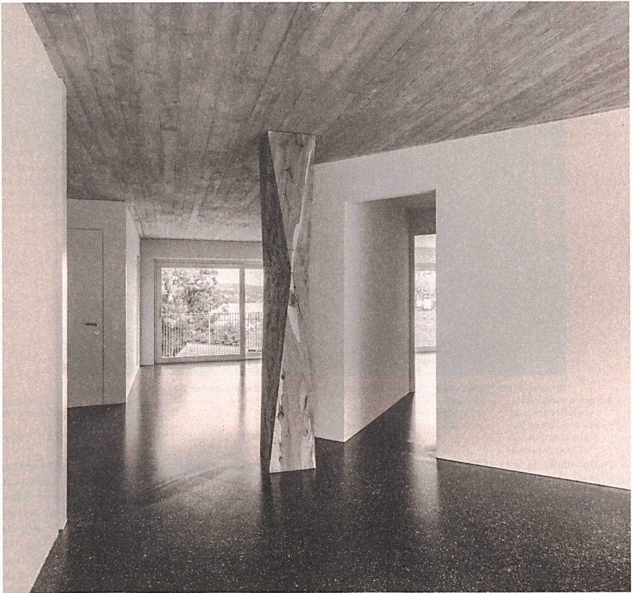
Der fließende Wohnraum verbindet See- und Hangseite. Zwei alte Eiben mussten dem Haus weichen. Ihre Bretter verkleiden nun die zentrale Stütze jeder Wohnung.
