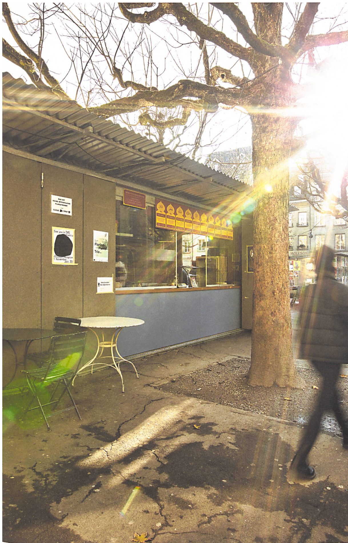
Unter dem auskragenden Wellblechdach klappt die Längswand des feingliedrigen Metallbaus zur Seite.
