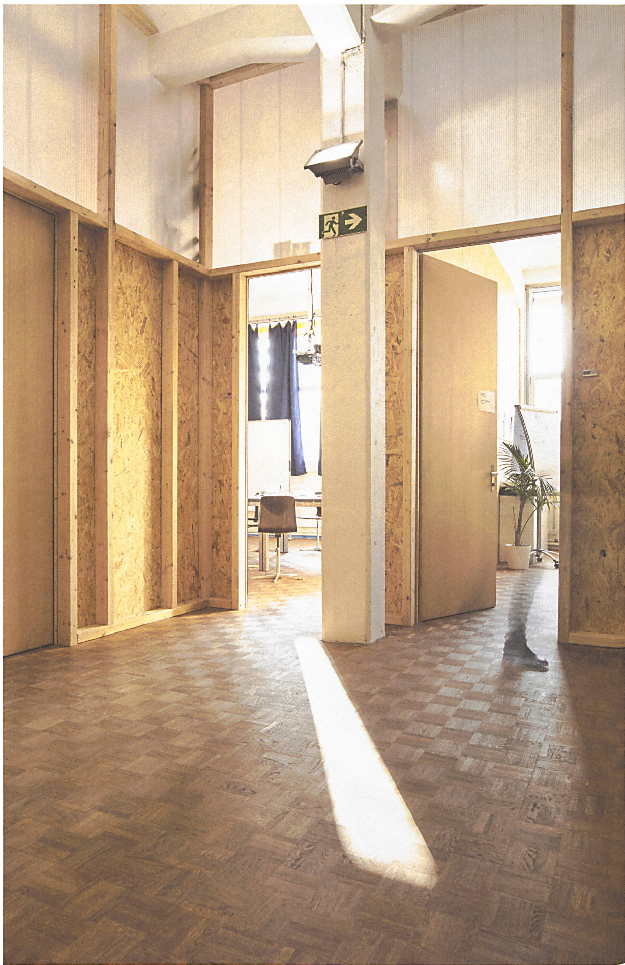
Büroeinbau für hundert Franken pro Kubikmeter: Beim «Drahtesel» im Liebefeld bei Bern gab das Mass der Grobspanplatten den Rhythmus vor.
