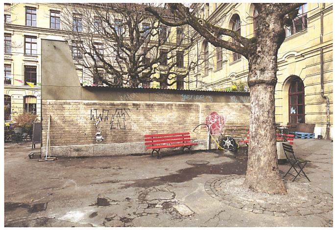
Keine inszenierte Spolie, sondern pragmatischer Weiterbau: Der Bar- und Imbisspavillon nutzt das Mauerfragment, seine Eternithülle integriert den Dampfabzug.
