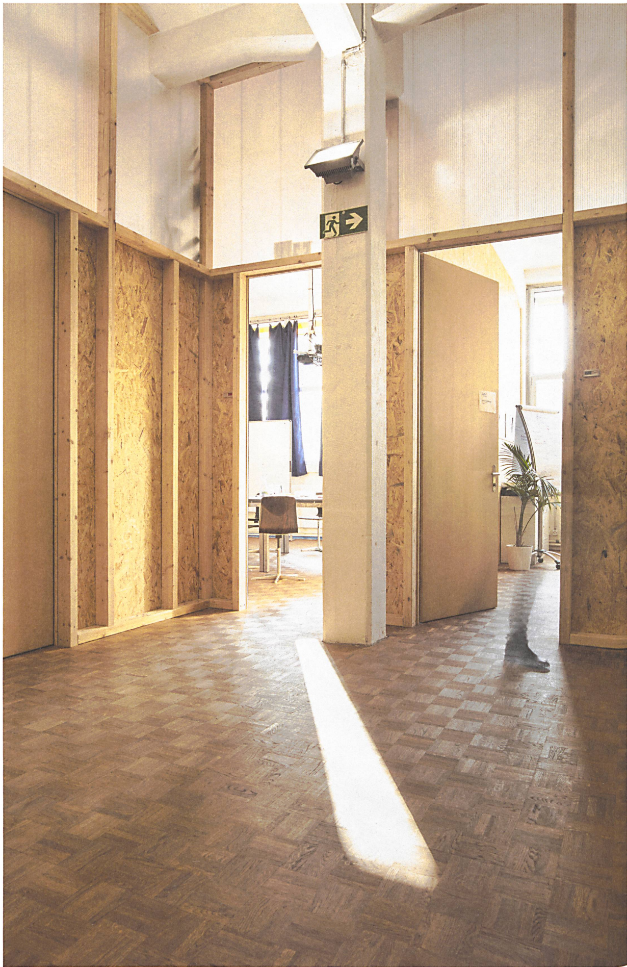
Büroeinbau für hundert Franken pro Kubikmeter: Beim «Drahtesel» im Liebefeld bei Bern gab das Mass der Gipsplatten den Rhythmus vor.
