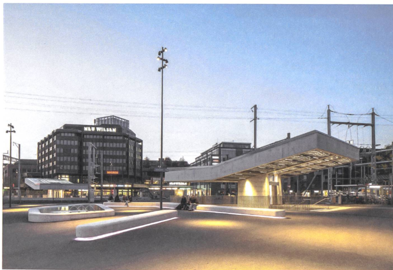
Die beiden Plätze der neuen Gleisquerung beim Bahnhof Winterthur, der Salzhausplatz ...
