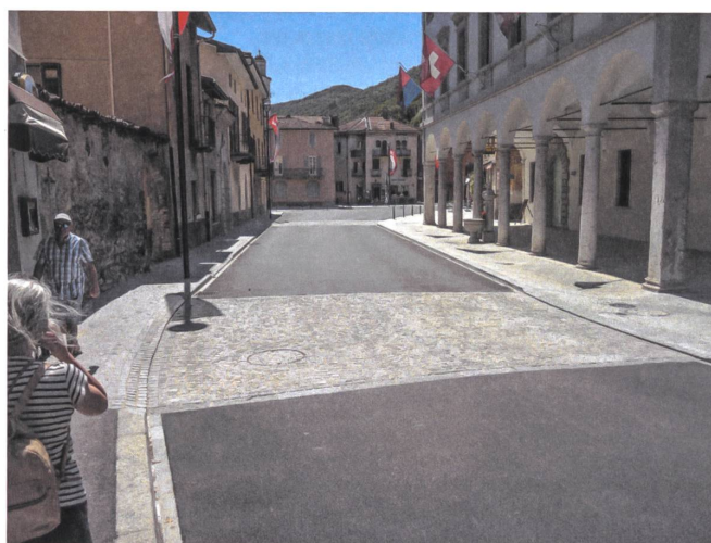
L'adozione di due diverse pavimentazioni induce il traffico motorizzato a moderare la velocità e a prestare maggiore attenzione.
