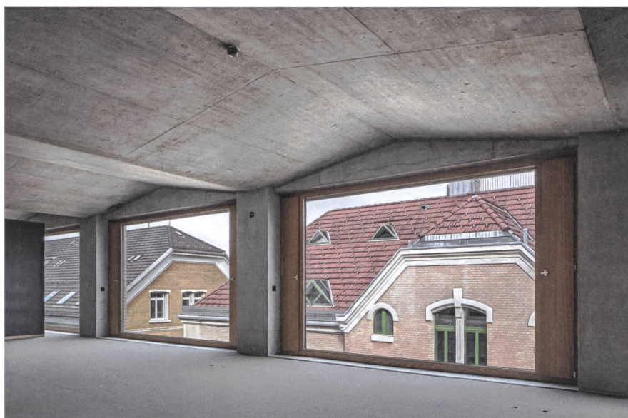
Eine gefaltete Betondecke prägt die offenen Büroräume.
