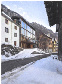
Ateliererweiterung, Haldenstein Atelier Peter Zumthor
