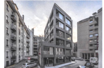
Mehrfamilienhaus rue Barton, Genf LRS architectes, Genf
