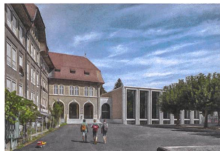
Turnhallen Schulhaus Hermesbühl, Solothurn Peter Moor, Zürich
