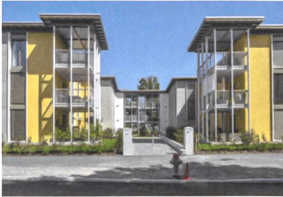
Ersatzneubau Schönauring, Zürich Knapkiewicz&Fickert, Zürich
