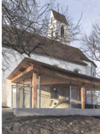
Foyer Alte Kirche, Boswil Gian Salls, Zürich
