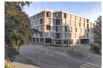
Wohnüberbauung Avenir, Renens Localarchitecture, Lausanne
