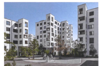
Siedlung Triemli 1, Zürich Hauenstein La Roche Schedler, Zürich
