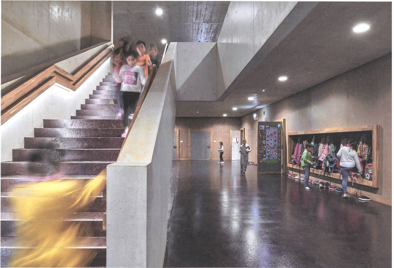
Die Materialien im Flur sind, was sie sind: Der Beton kaschiert die Spuren der Baustelle nicht, am Boden liegt Gussasphalt, die Wände sind mit Rupfen verkleidet.
