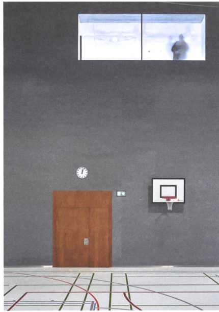
Der Filz schluckt auch in der Turnhalle den Schall.
